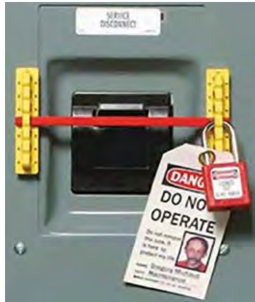
Figura 3. Sistema para la puesta a tierra y en cortocircuito para transformadores, ( www.emdesa.com.ar ) y Bloqueo y etiquetado de un interruptor ( www.logismarket.com.ar )
