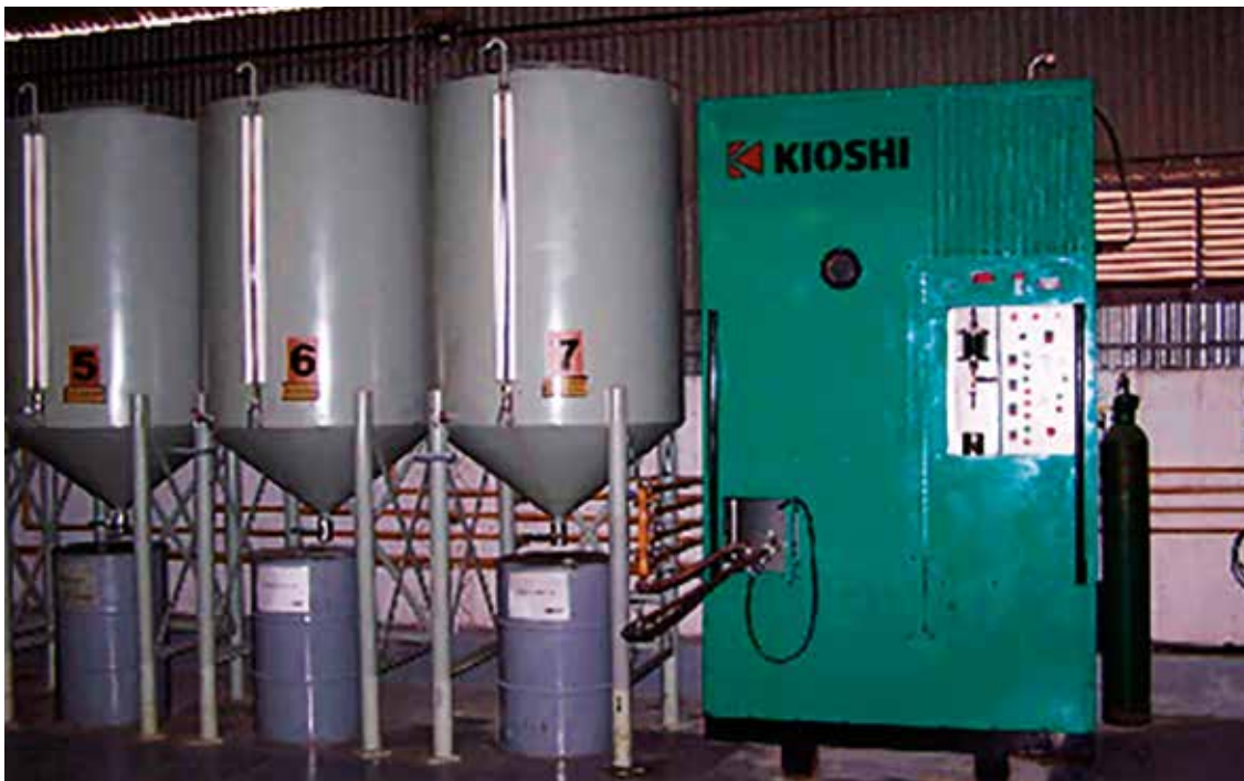
Figura 31. Reactor y tanques de precipitación 69
